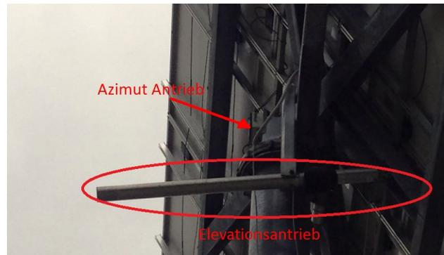
Abbildung 8: Antriebe der Fotovoltaikanlage
