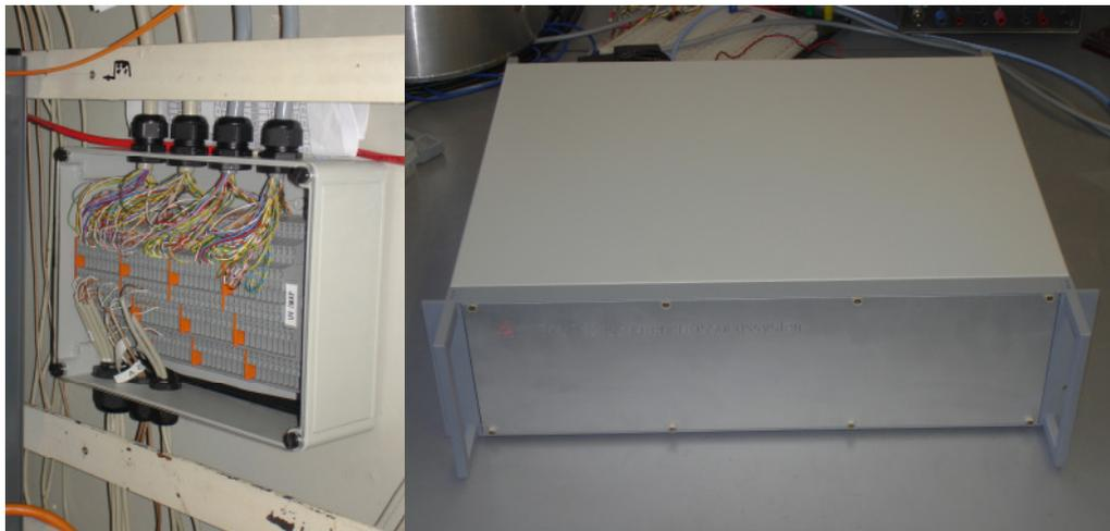
*Abb. 72: EMAP-Unterverteilung in Primärfokuskabine (links) mit Sensor- u. Steuergerätezuleitungen (unten) und Signalleitungen für Einschub (oben); Geschlossener Einschub des Messdatenerfassungssystems (rechts)*
