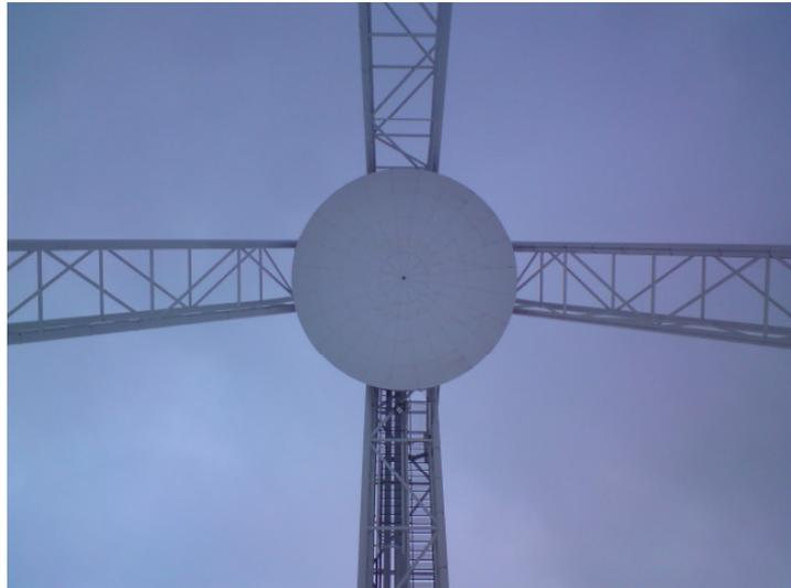
**Abbildung 8: Der Sekundärspiegel**
